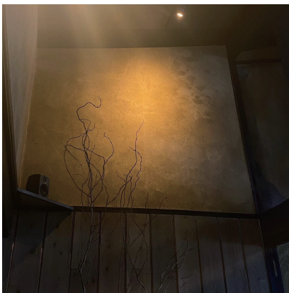
コーヒーが練りこまれた土壁
